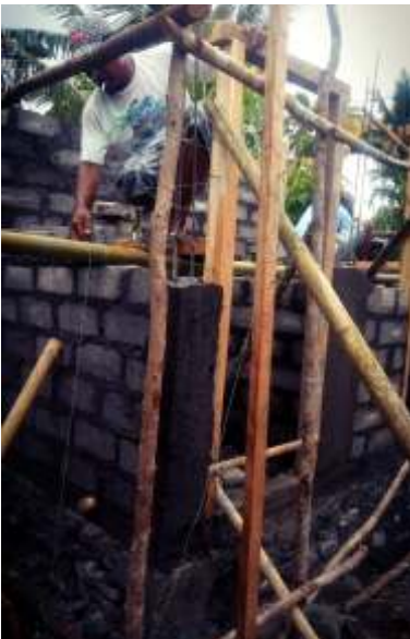
bouw van een nieuwe WC
